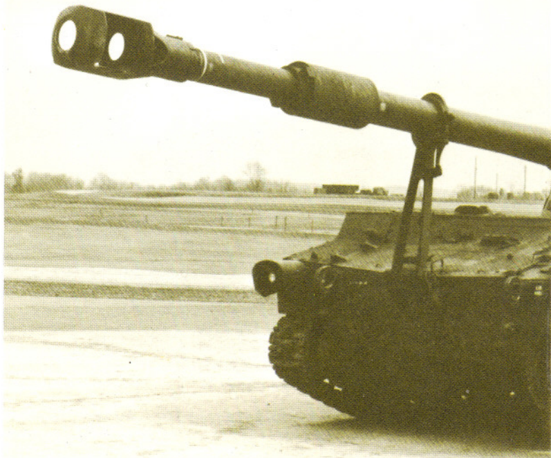
Fent: Az M109A1 prototípusa, az M109A1E1 az USA Szárazföldi Erő Aberdeen próbapályáján, Marylandben. Maximum 19 685 yard (18 000 m) távolságra tüzelhetett
